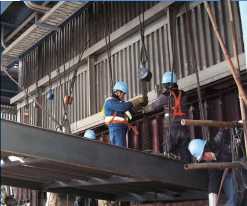
▲ 改造工程施工现场
