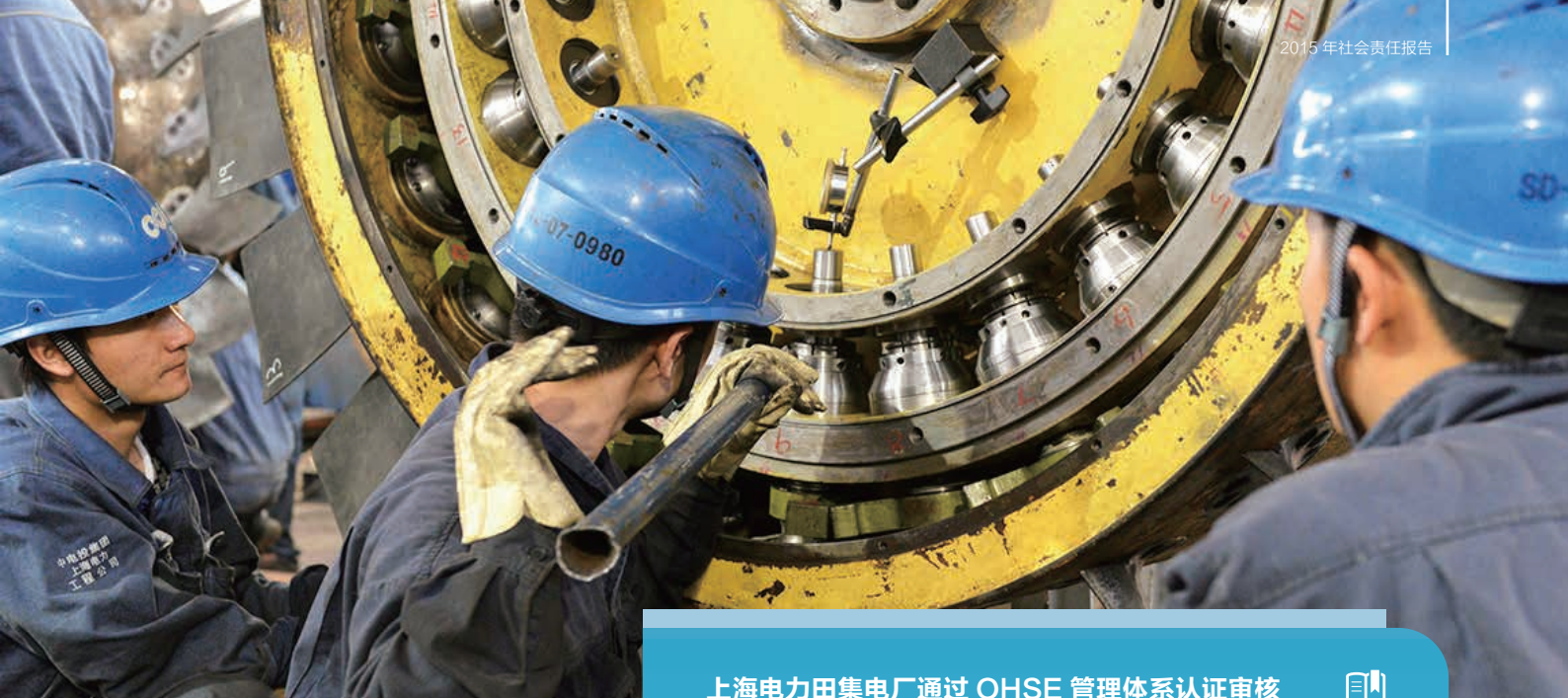
▲ 动叶可调式轴流风机检修现场
