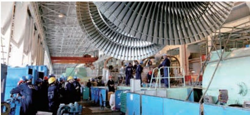
▲ 外高桥大修现场
