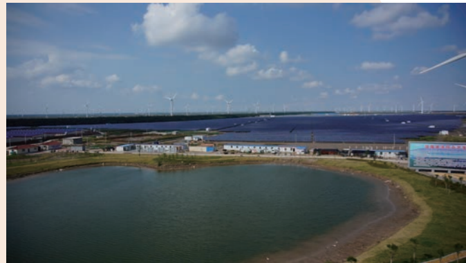
江苏东台 50 兆瓦光伏电站
