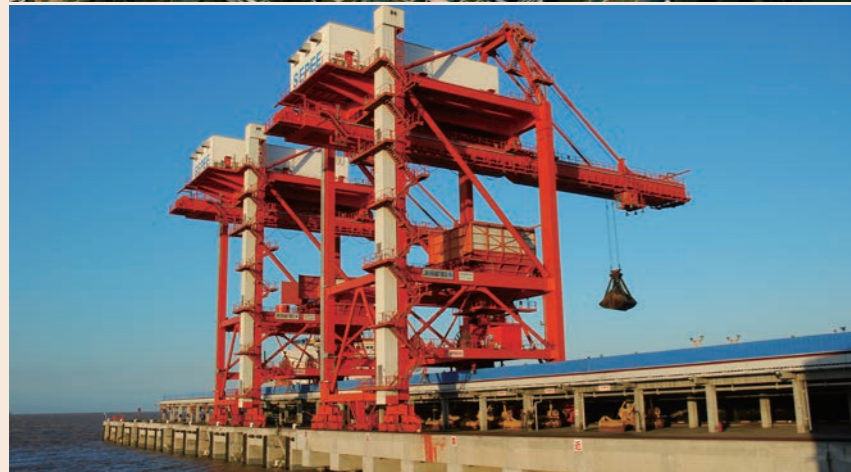
漕泾电厂卸煤码头
