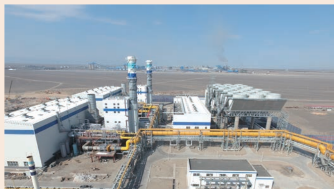
建设中的新疆哈密燃机项目
