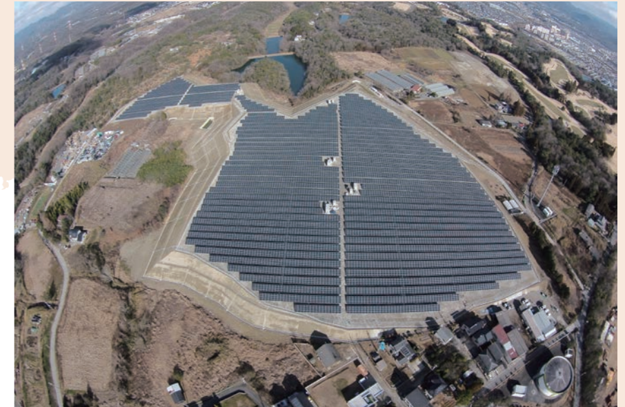
日本兵库三田光伏项目
